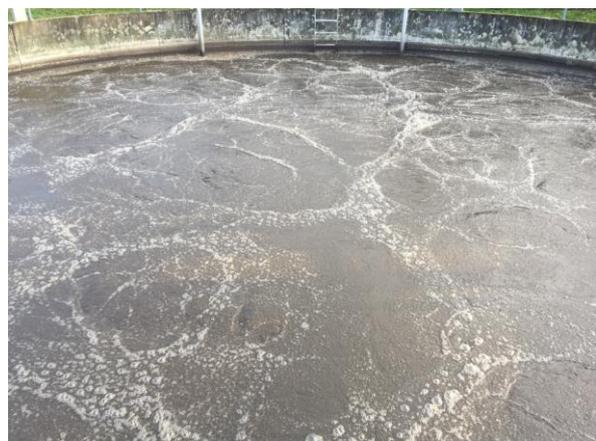
Links der neue Rechen, rechts die feinblasige Belüftung auf der Kläranlage Ried (Fotos GKU Betriebsleitung)
