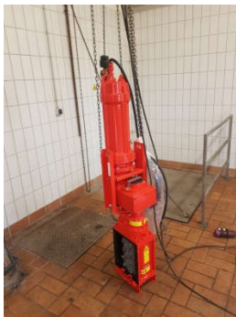
Bild 1: Mazerator zur Zerkleinerung von Faserstoffen im Abwasser
